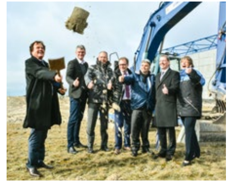
Zusammen mit 300 Gästen feierte das Nordfrost-Team rund um Horst Bartels (links) am 2. März 2017 den ersten Spatenstich
